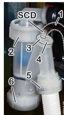
Система відводу конденсату повинна монтуватися таким чином, щоб виключити можливість замерзання конденсату. Перед пуском котла в експлуатацію необхідно переконатися в правильному відводі конденсату. Сифон конденсату має додатковий вихід SCD на той випадок, якщо видалення конденсату через канал у нижній частині сифона якимось чином заблоковано.
